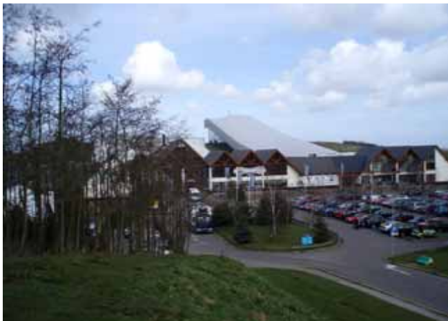
Figuur 2.1 Huidig gebouw
